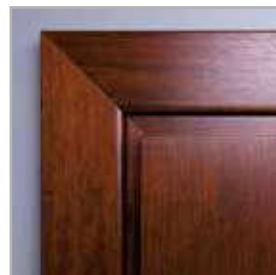
łączenie opasek pod kątem 45°
