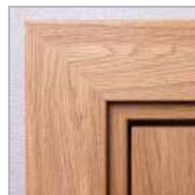
standardowe łączenie opasek pod kątem 45°
